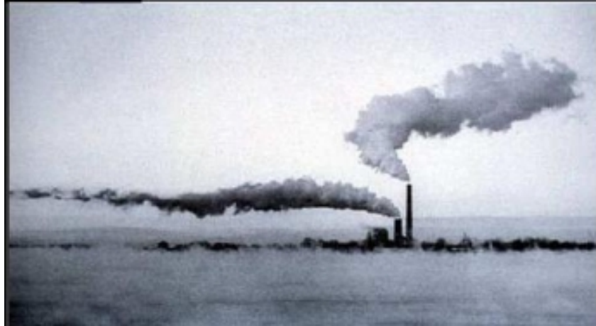
FIG. 1.2 – Illustration de l'importance de prendre en compte la météorologie à la hauteur exacte d'émission, et non à une hauteur moyenne : deux panaches émis à des hauteurs différentes partent dans des directions opposées.
